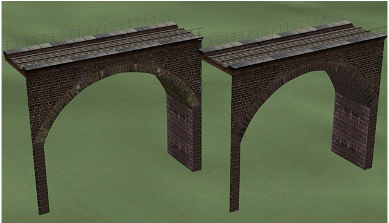
Gleisobjekte Biehl_1_HBogen_G_AF1 (links) und Biehl_1_HBogen_R_AF1 , 20 m lange und 16 m hohe Gewölbebogen für Gleisstile mit Schotterbett bis 6 m Breite
