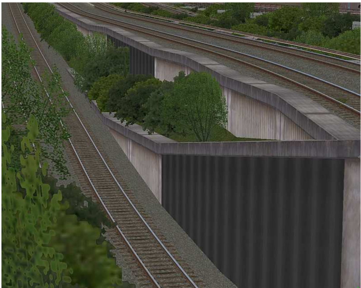
Mix aus Mauer und Spundwand Immobilien
