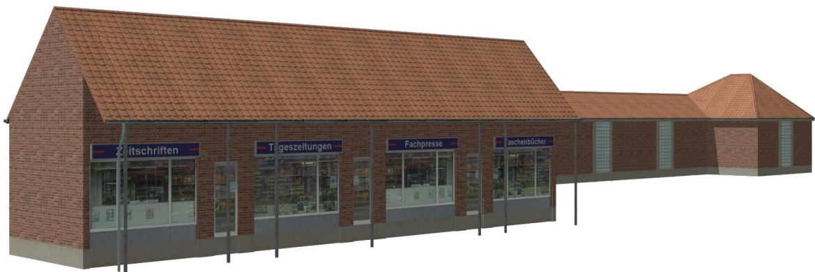
Bhf Nienburg Nebengebäude
